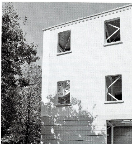
Nuova scala di emergenza Facoltà di Agraria. Particolare lato sud.
